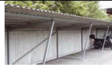
Fassaden/Dächer aus Asbestzement Velounterstände, Gebäudefassaden usw.
