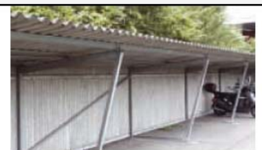
Fassaden / Dächer aus Asbestzement Velounterstände, Gebäudefassaden usw.
