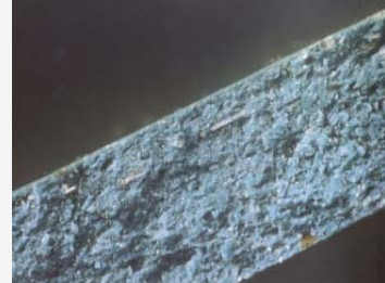
Einschichtiger Bodenbelag (Asbest integriert)
