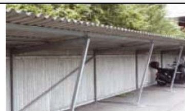
Fassaden/Dächer aus Asbestzement Velounterstände, Gebäudefassaden usw.
