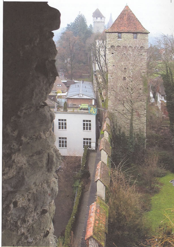
Abb. 1: Mueseggmauer Luzern: Aussicht auf westlichen Mauerabschnitt und Türme. Ein komplexes Bauwerk, für das sich eine GIS-Anwendung anbietet.
